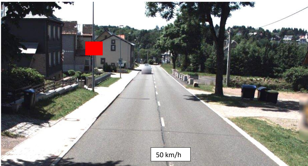
Straßenbeleuchtungsmast vor Alte Ilmenauer Straße 10, aus Ri. Stützerbach
