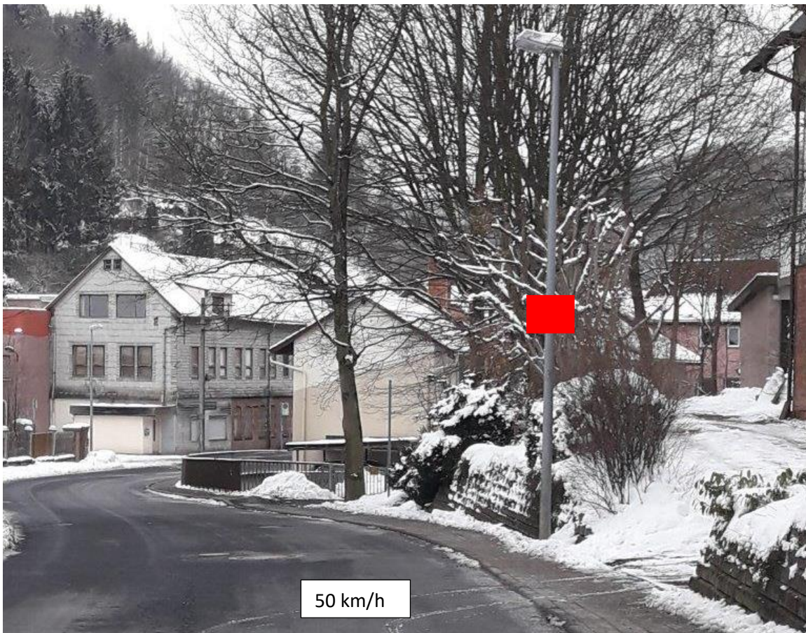
Straßenbeleuchtungsmast vor Lauter 31, aus Ri. Goldlauter-Heidersbach
